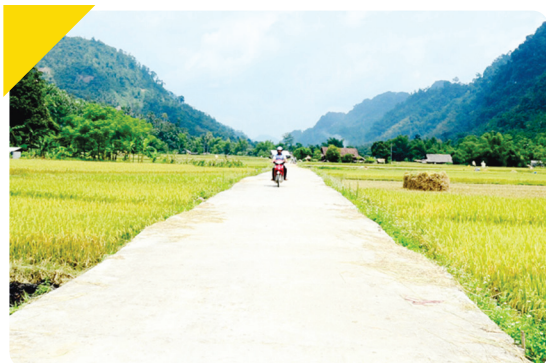
Tuyến Đường Giao Thông Nội Đồng Của Thôn Lung May, Xã Khuôn Hà, Huyện Lâm Bình
